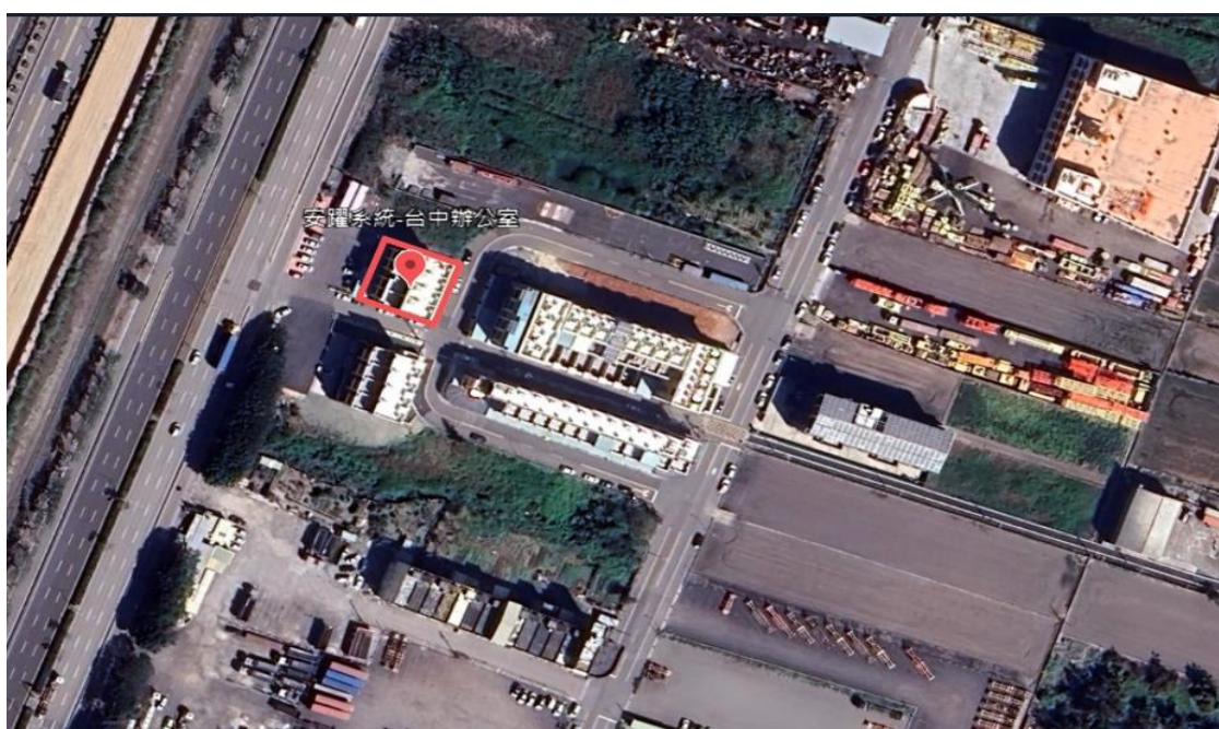
安躍-台中辦公室(3 樓部分場域) 地址: 台中市清水區臨港路五段 660 號 3 樓
